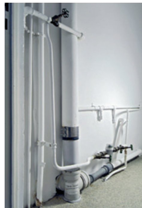
↑ Geberit GIS – najszybsze i prawdopodobnie najtańsze rozwiązanie umożliwiające przekształcenie takiego pomieszczenia w atrakcyjną łazienkę.
