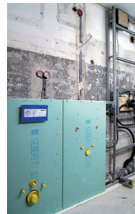
↑ Prawidłowo zamontowana i częściowo pokryta płytami g-k ściana łazienki z podłączeniami do baterii i ceramiki.
