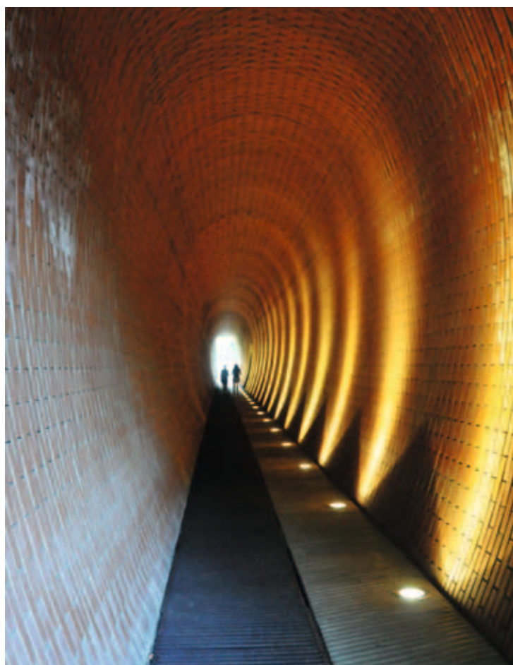
TUNEL POD JELENIĄ FOSĄ, PROJ. JOSEF PLESKOT AP ATELIER (1996–2002)
