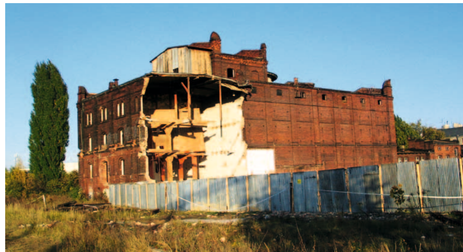
NISZCZĄCA ZABUDOWA PRZEMYSŁOWA
