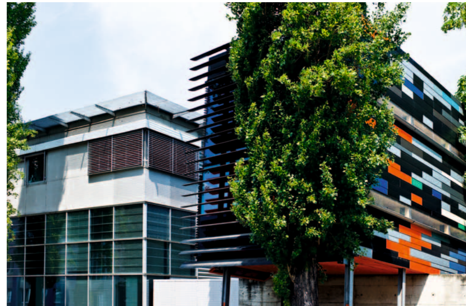
SHOWROOM FABRYKI OKŁADZIN SIPRAL, PROJ. D3A FIALA PROUZA ZIMA (1999–2006)
